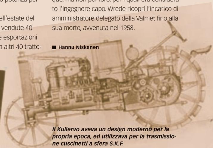
*Il Kullervo aveva un design moderno per la propria epoca, ed utilizzava per la trasmissione cuscinetti a sfera S.K.F.*
